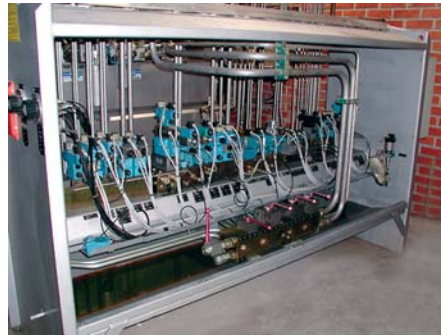
Kuva 23. Kirjahyllymallinen teline sijoittuna ohjattavan laitteen alapuolelle. Väilaaattarakenteiset venttiilit on asennettu ryhmäpohjalaattaan /24/.
