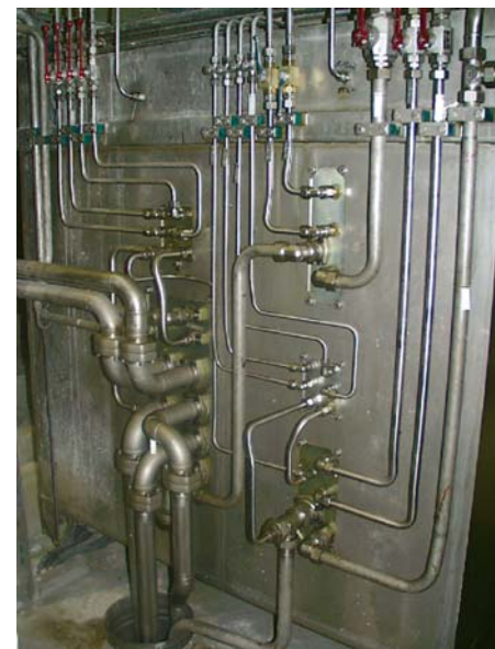
Kuva 26. Perinteinen venttiililinet, jossa putket on keskitetty asennuslevyn takapuolelle /23/.
